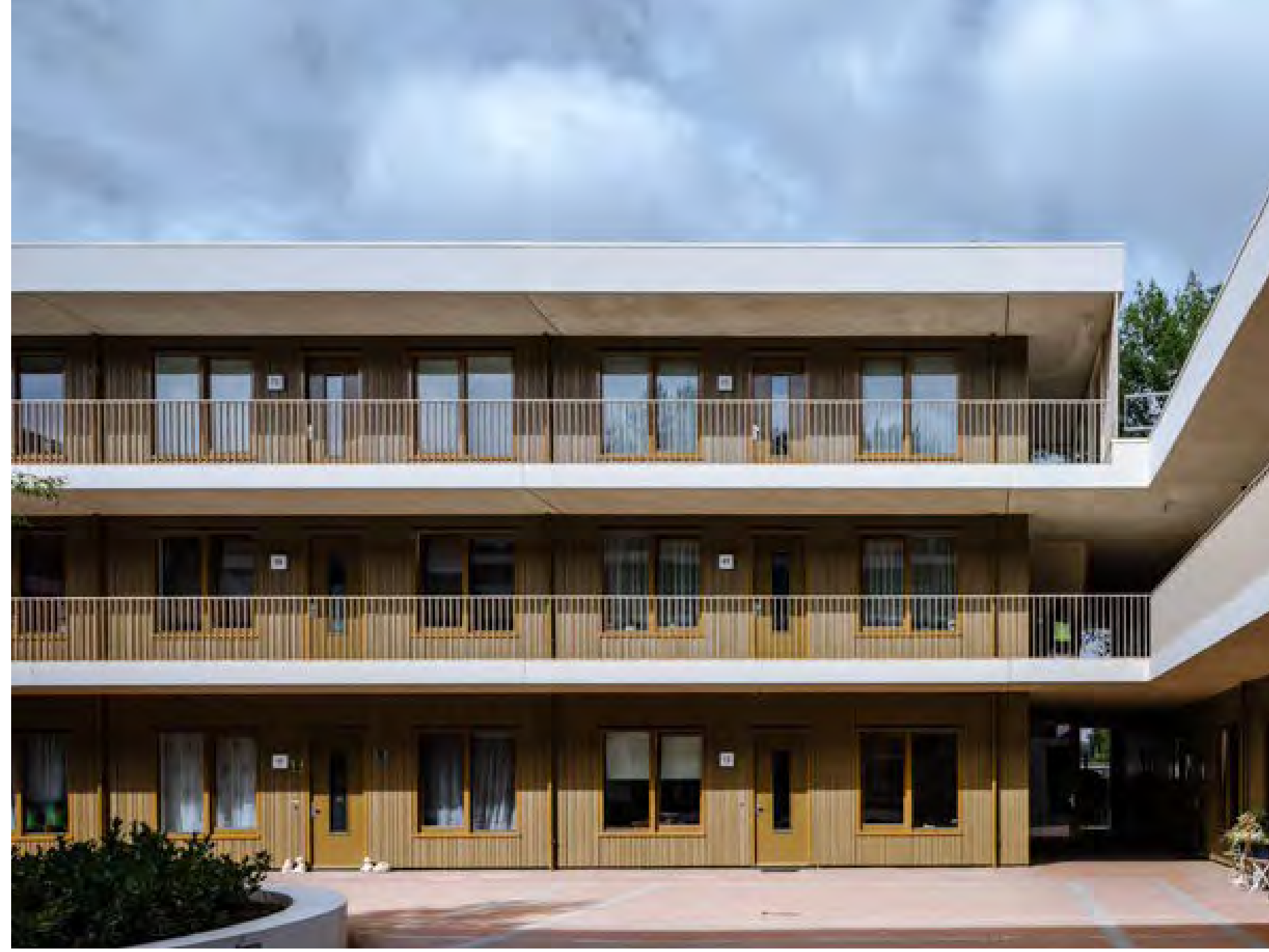
galerij en woningentrees op begane grond
