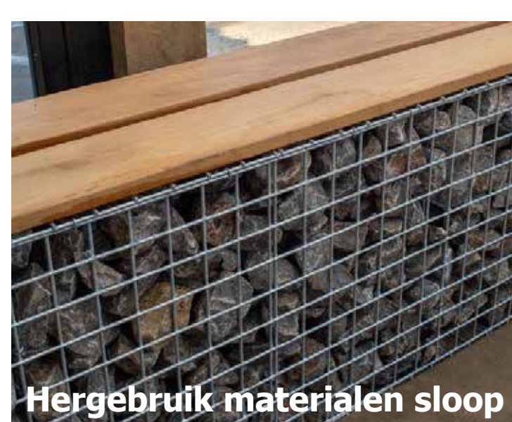
Hergebruik materialen sloop
