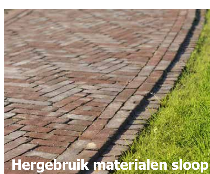
Hergebruik materialen sloop
