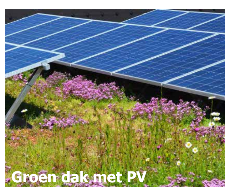
Groen dak met PV
